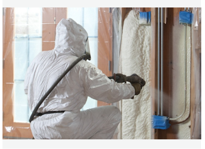
Sprey PU uygulaması / Spray PU application
